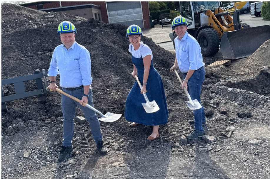
Spatenstich für das neue JOKARI-Logistikzentrum in Ascheberg.
